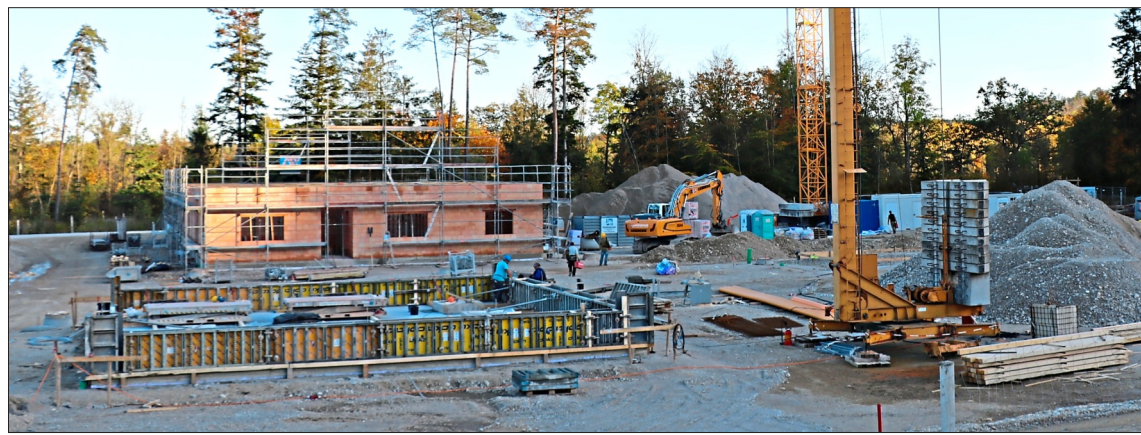
Nimmt langsam Formen an: In Bruck bei Garching wird seit August gebaut. Im Sommer 2020 soll die Geothermie-Anlage den Betrieb aufnehmen. – Foto: Stummer/Grafik: Silenos Energy
